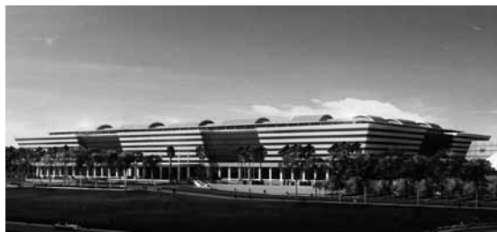
รูปที่ 1 ทศนิยมภาพในส่วนอาคารรวมหน่วยราชการโครงการศูนย์ราชการเฉลิมพระเกียรติ ๘๐ พรรษา ๕ ธันวาคม ๒๕๕๐
