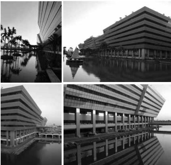
รูปที่ 21 บรรยากาศบริเวณบ่อน้ำรอบอาคารรวมหน่วยราชการ (บน) ภาพบ่อน้ำทิศเหนือและทิศตะวันออก เป็นบ่อนบนโครงสร้าง (ล่าง) ภาพบริเวณด้านทิศใต้และทิศตะวันตก เป็นบ่อนดินขนาดใหญ่ ลึกประมาณ 3.5 เมตร
