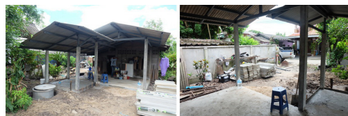
รูปที่ 10 การจัดเตรียมงานโครงสร้างโดยช่างชาวบ้าน
