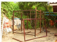
ประกอบและติดตั้งชิ้นส่วนโครงสร้าง
