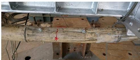
รูปที่ 5 ลักษณะการวิบัติแบบ local crushing threaded rods and Failure splitting ที่เกิดขึ้นบริเวณระหว่างหัวน็อต (เหล็กเกลียวตลอด)
