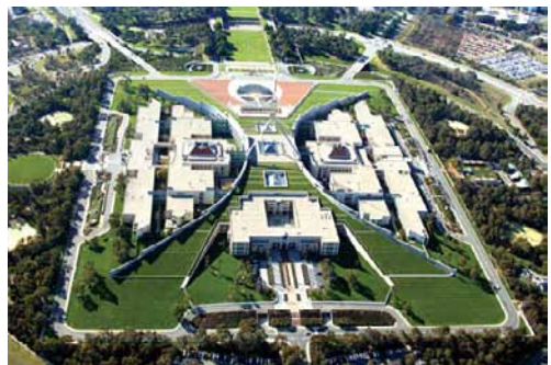
รูปที่ 3 ลักษณะหลังคาของอาคารรัฐสภาประเทศออสเตรเลีย ที่ผสมผสานภูมิสถาปัตยกรรมเข้ากับอาคาร เพื่อสร้างเป็นพื้นที่ใช้งาน
