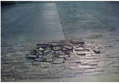
ที่มา: บริษัทแกรนด์ ยูนิตี้ ดีเวลลอปเม้นท์ จำกัด รูปที่ 9 ตัวอย่างข้อบกพร่องในการใช้หินกาบในการ ตกแต่งถนนส่วนกลาง
