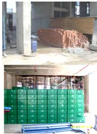
ที่มา: บริษัทแกรนด์ ยูนิตี้ ดีเวลลอปเม้นท์ จำกัด รูปที่ 5 การนำอิฐบรรจุลงในตะกร้าพลาสติกเพื่อขนส่ง ได้รวดเร็วและลดการแตกหัก
