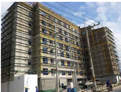
รูปที่ 7 สถานที่ก่อสร้างจริงของอาคาร D
