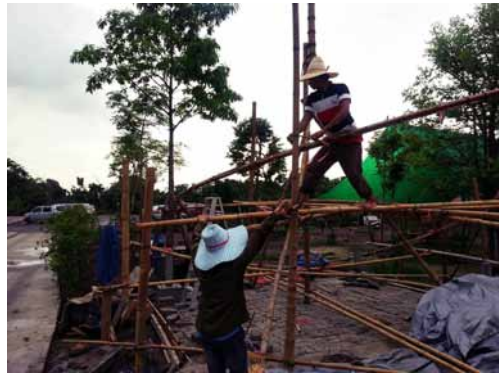
รูปที่ 1 การเตรียมงานก่อสร้างอาคารไม้ไผ่แบบในที่
