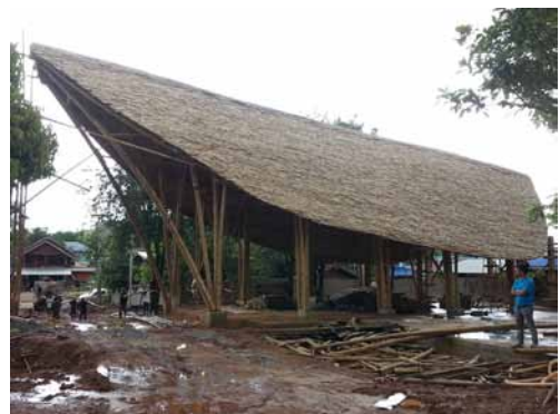
รูปที่ 6 อาคารไม้เฟรมโครงสร้างแบบซับซ้อน
