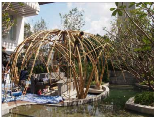
รูปที่ 4 การก่อสร้างอาคารไม้เฟรมแบบกึ่งสำเร็จรูป
