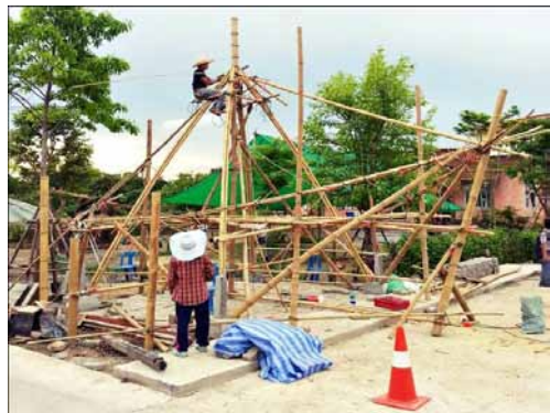
รูปที่ 2 การก่อสร้างอาคารไม้ไผ่แบบในที่
