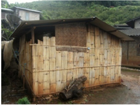
ที่มา: จากการสำรวจหมู่บ้านปางม้า ดอยอ่างขาง รูปที่ 13 ฝาผนังฟากลับ ที่อยู่อาศัยของชาวเขา
