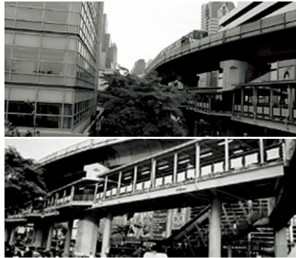
รูปที่ 5 ทางเดินเชื่อมระหว่างสถานีศาลาแดง และสถานีสีลม
