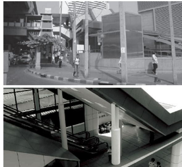
รูปที่ 7 ทางเดินเชื่อมระหว่างสถานีอนุโตก และสถานีสุขุมวิท
